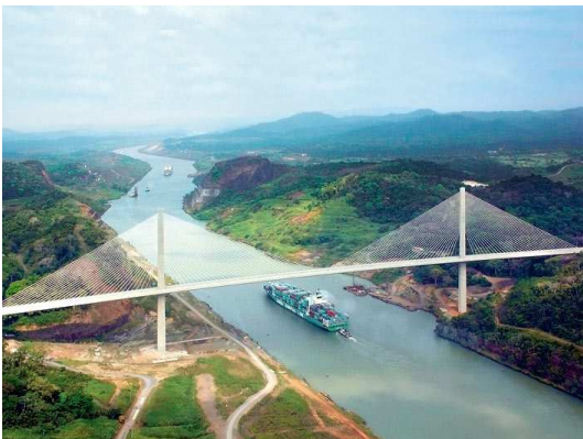
Puente de Centenario, Panama Foto: Bilfinger Berger
