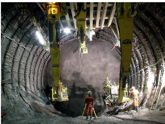
Gotthard-Basistunnel, Schweiz Foto: Bilfinger Berger
