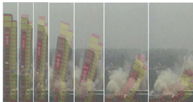
Sprengsimulation Sparkasse Hagen – Vergleich reale Sprengung und Simulation – DFG FOR 500
