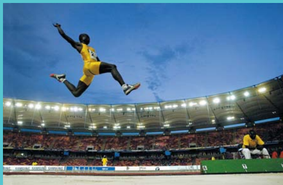
National Stadium, Abuja, Nigeria Im Oktober 2003 trafen sich 6.000 Athleten in Nigerias Hauptstadt Abuja zu den 8. All Africa Games. Hauptaustragungsort war das von Bilfinger Berger in weniger als zweieinhalb Jahren betriebsfertig errichtete National Stadium. Foto: Bilfinger Berger
