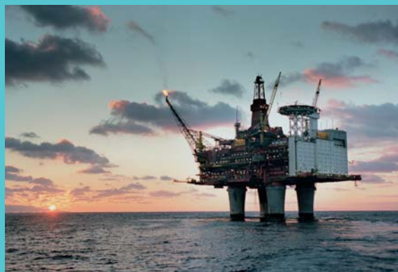
Förderplattformen, Norwegen Rheinhold & Mahla, Spezialist für Industriedienstleistungen im Bilfinger Berger Konzern, ist einer der führenden Anbieter für Wartung und Instandhaltung von Förderplattformen in der Nordsee. Die Gesellschaft ist leistungsfähiger Partner der Öl- und Gasindustrie. Foto: Bilfinger Berger
