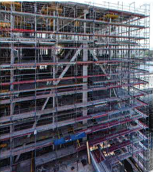
Humboldt/HafenEins Megatruss (Foto: Bilfinger)
