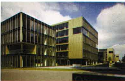
ThyssenKrupp Campus Essen (Foto: Bilfinger)
